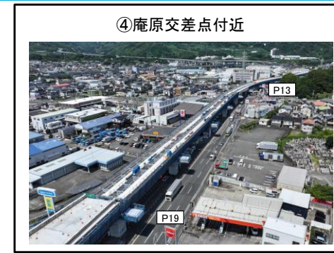
P13~P19橋脚 床板工 施工中
