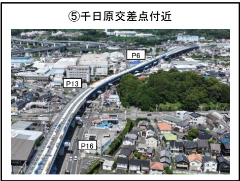
P6橋脚~P13橋脚 床版工 施工中
