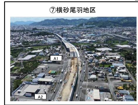
A1橋台、A2橋台間 擁壁工 施工中
