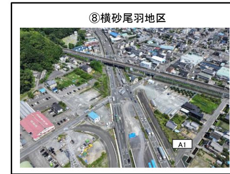
A1橋台、A2橋台間 擁壁工 施工中
