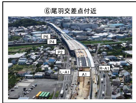
P2橋脚~P6橋脚 床版工 施工中 A1橋台~P2橋脚 床版工 施工中
