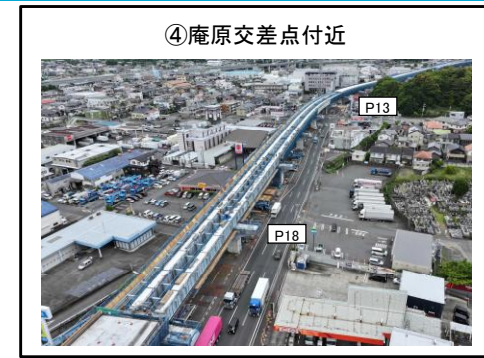
P13~P19橋脚 上部工 施工中
