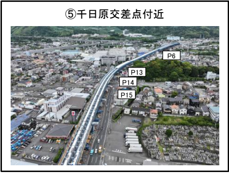
P6橋脚~P13橋脚 床版工 施工中
