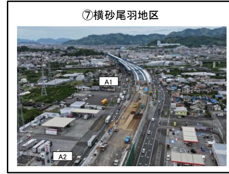
A1橋台、A2橋台間 擁壁工 施工中
