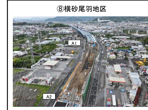
A1橋台、A2橋台間 擁壁工 施工中
