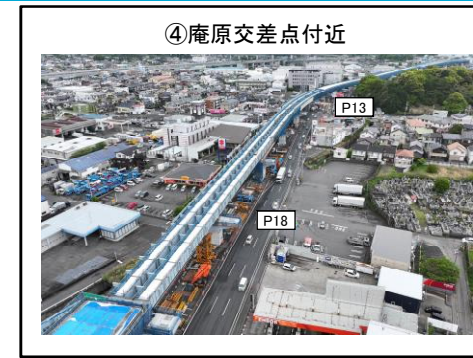
P13～P19橋脚 上部工 施工中
