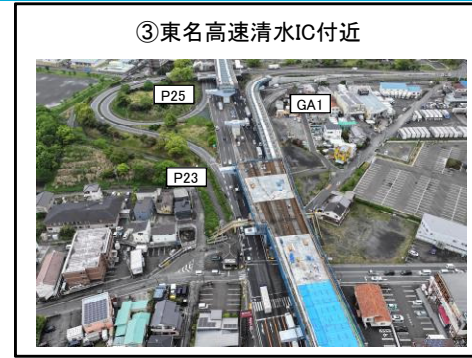
P19～P23橋脚 床版工 施工中 GA1～P23橋脚 上部工 施工中
