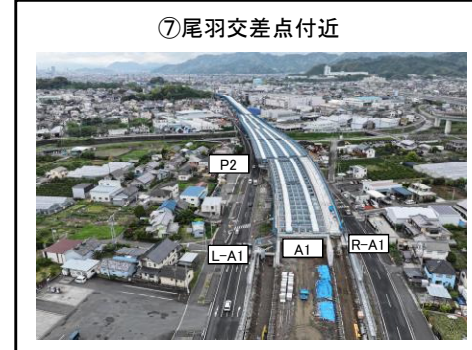
A1橋台～P2橋脚 上部工 施工完了 RA1橋台～P2橋脚 オフランプ床版工 施工中
