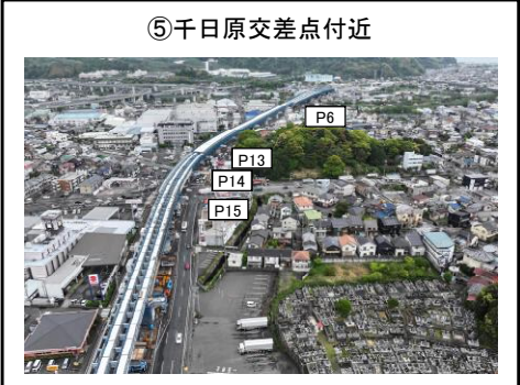
P6橋脚～P13橋脚 床版工 施工中
