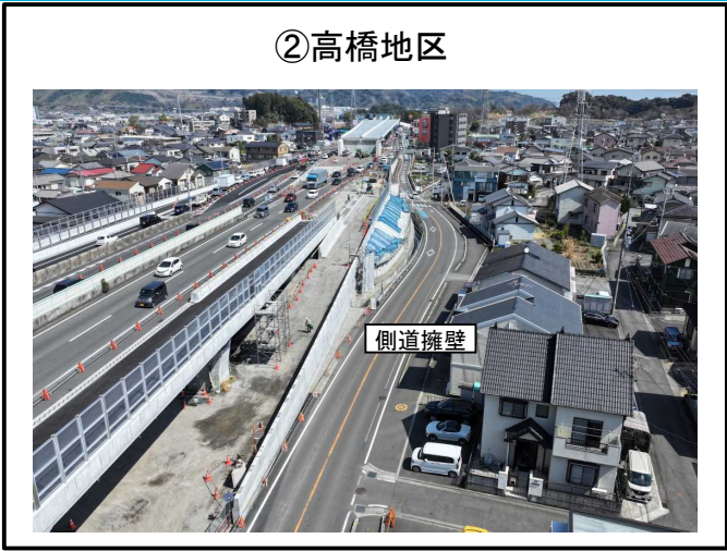
側道 擁壁 施工中
