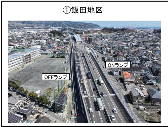
飯田ON・OFFランプ合流部 舗装工 施工中
