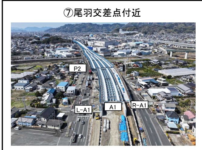
A1橋台～P2橋脚 上部工 施工完了 A1橋台～P2橋脚 オフランプ床版工 施工中
