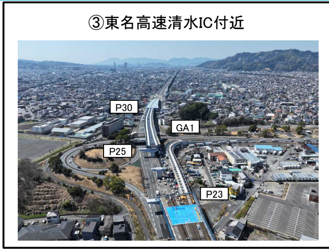
P19～P23橋脚 床版工 施工中 P25～P30橋脚 上部工 施工中 GA1～P23橋脚 上部工 施工中
