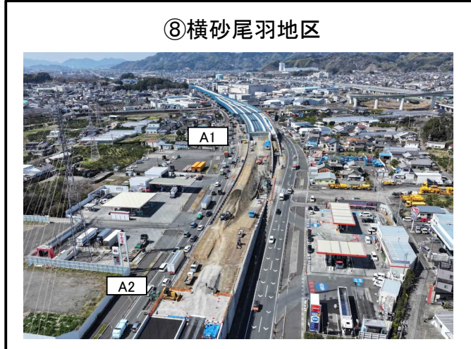
A1橋台、A2橋台間 擁壁工 施工中
