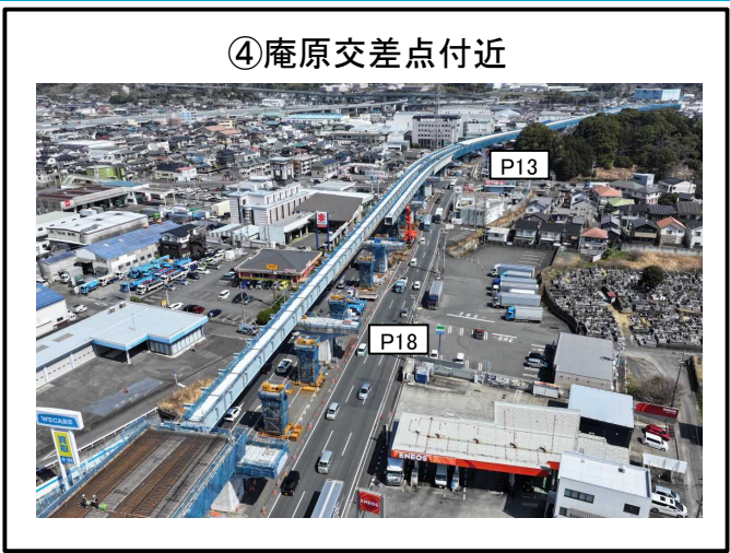
P13～P19橋脚 上部工 施工中
