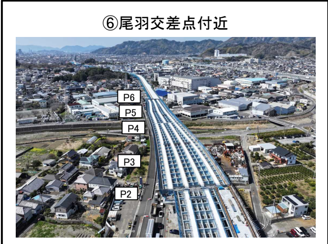
P2橋脚～P6橋脚 上部工 施工完了
