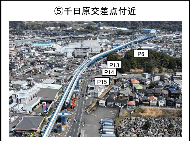
P6橋脚～P13橋脚 床版工 施工中
