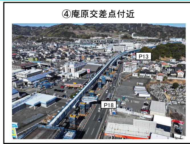
P13～P19橋脚 上部工 施工中
