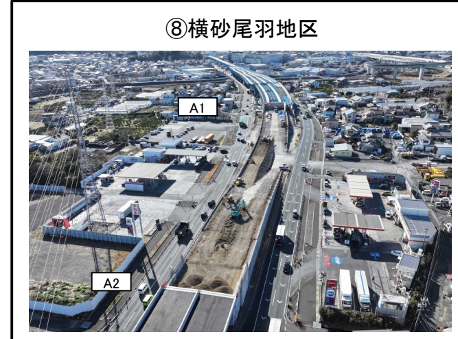
A1橋台、A2橋台間 擁壁工 施工中
