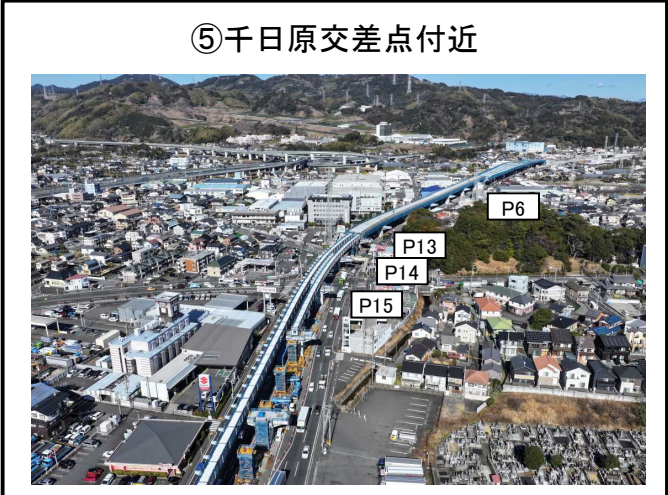
P6橋脚～P13橋脚 床版工 施工中
