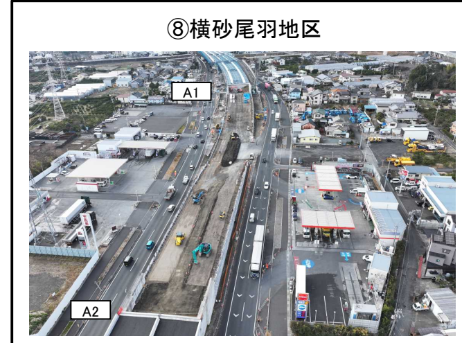
A1橋台、A2橋台間 擁壁工 施工中
