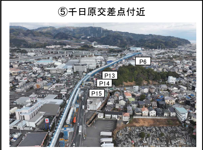
P6橋脚～P13橋脚 床版工 施工中
