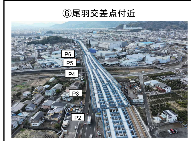
P2橋脚～P6橋脚 上部工 施工中
