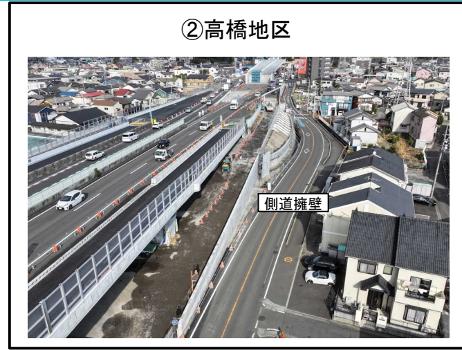
側道 擁壁 施工中
