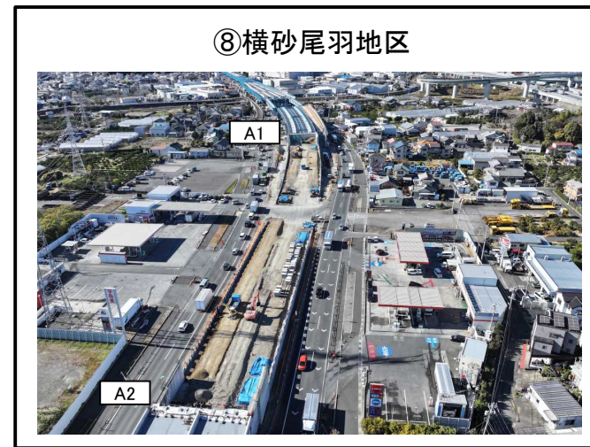
A1橋台、A2橋台間 擁壁工 施工中
