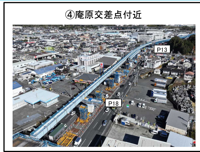
P13～P19橋脚 上部工 施工中
