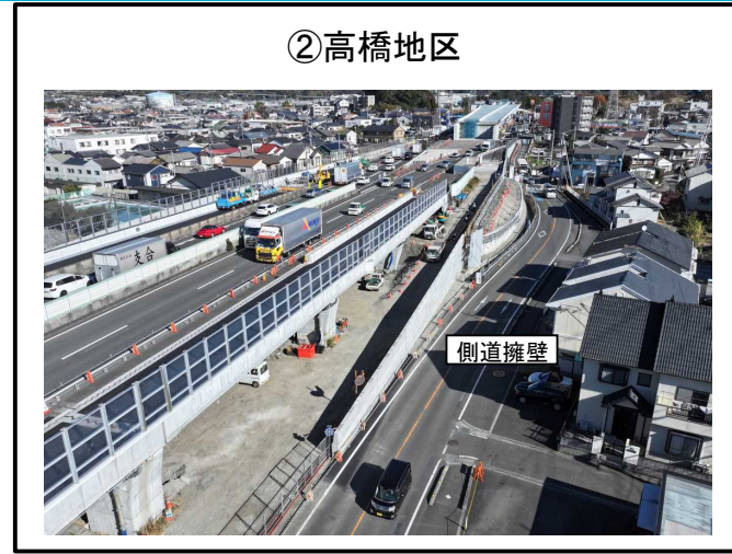
側道 擁壁 施工中
