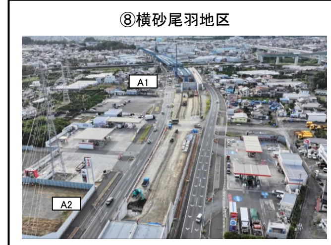
A1橋台、A2橋台間 擁壁工 施工中
