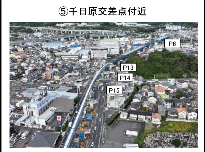
P6橋脚～P13橋脚 床版工 施工中
