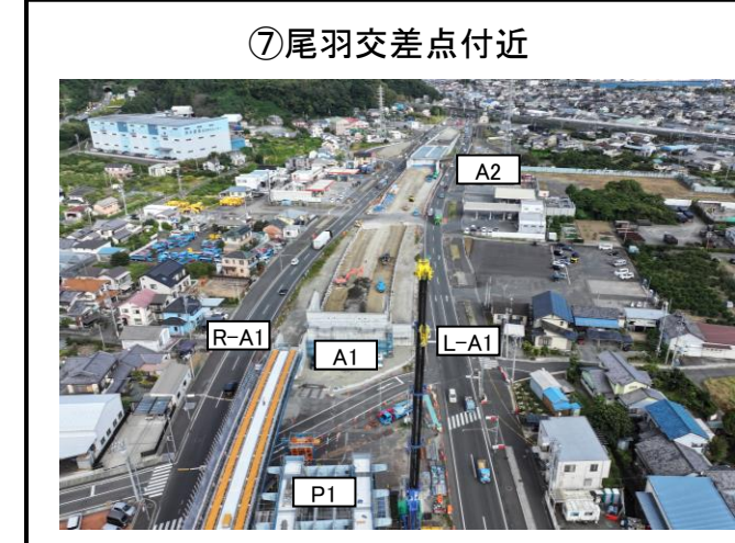
A1橋台～P2橋脚 上部工 施工中 A1橋台～P2橋脚 オフランプ床版工 施工中
