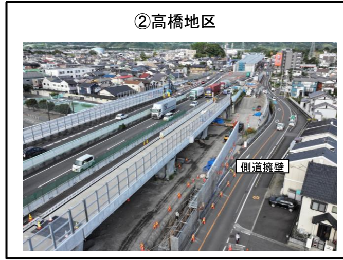
側道 擁壁 施工中
