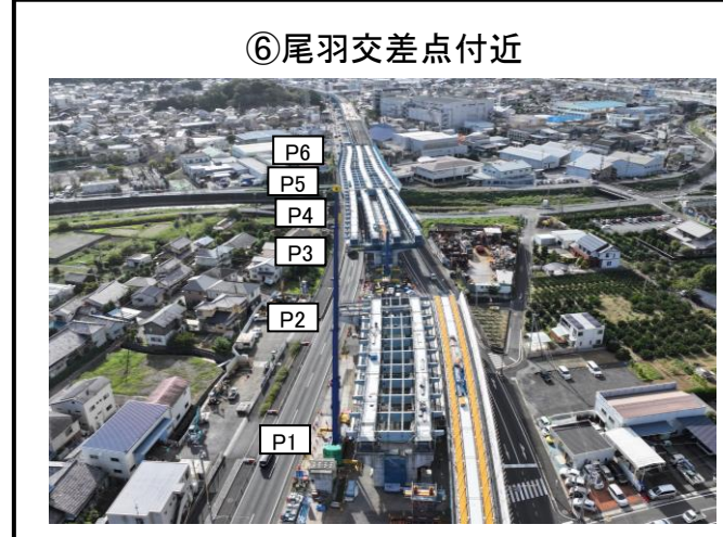
P2橋脚～P6橋脚 上部工 施工中
