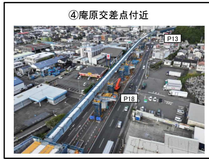
P13～P19橋脚 上部工 施工中
