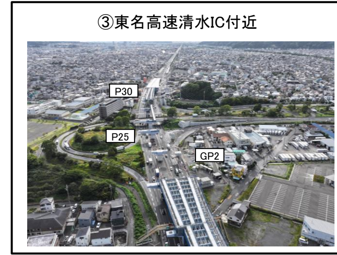
GP2橋脚 下部工 施工完了 P19～P23橋脚 床版工 施工中 P25～P30橋脚 上部工 施工中
