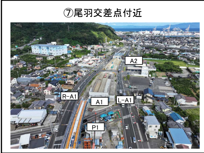
A1橋台、A2橋台間 擁壁工 施工中 A1橋台~P2橋脚 上部工 施工中 A1橋台~P2橋脚 オフランプ床版工 施工中
