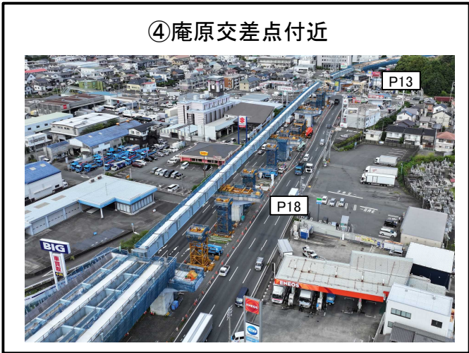
P13~P19橋脚 上部工 施工中
