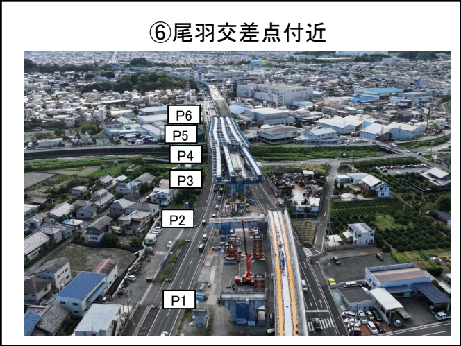
P2橋脚~P6橋脚 上部工 施工中
