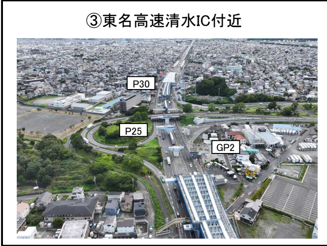
GP2橋脚 下部工 施工中 P25~P30橋脚 上部工 施工中
