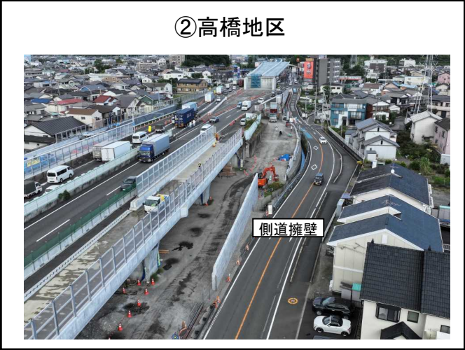
側道 擁壁 施工中
