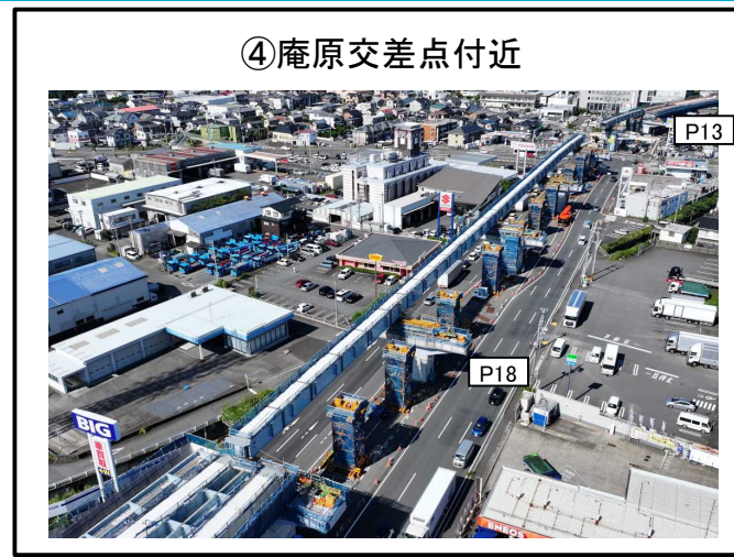
P13~P19橋脚 上部工 施工中
