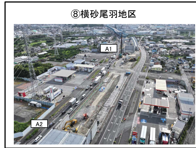
A1橋台、A2橋台間 擁壁工 施工中
