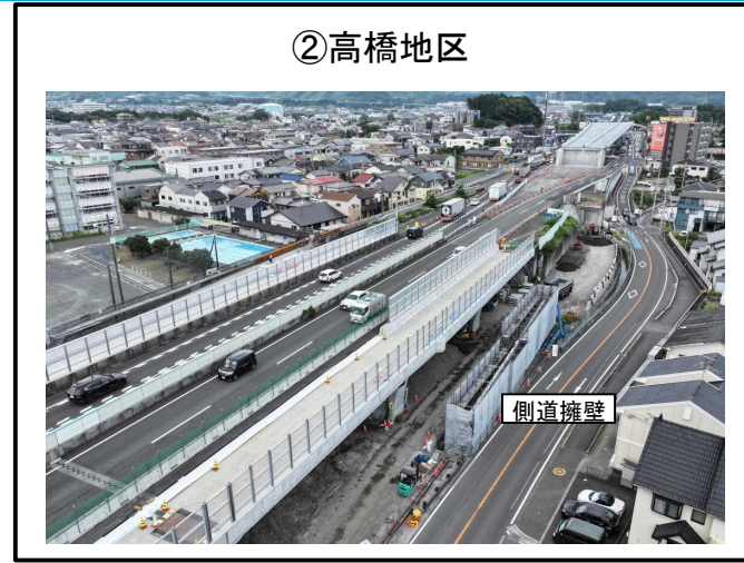
側道 擁壁 施工中
