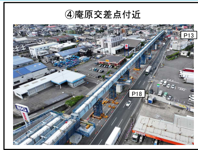
P13～P19橋脚 上部工 施工中
