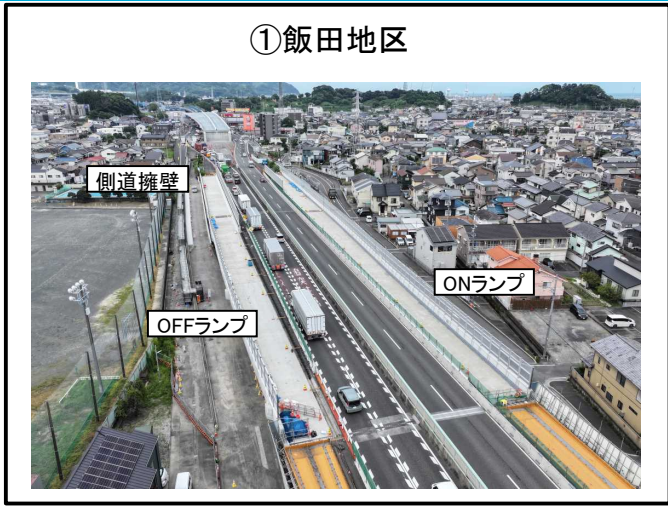
飯田ON・OFFランプ合流部 床版工 施工中 側道 擁壁 施工中
