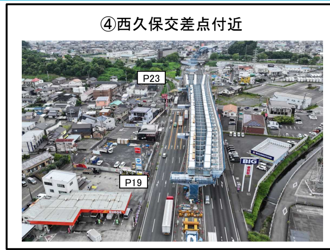
P19～P23橋脚 上部工 施工中
