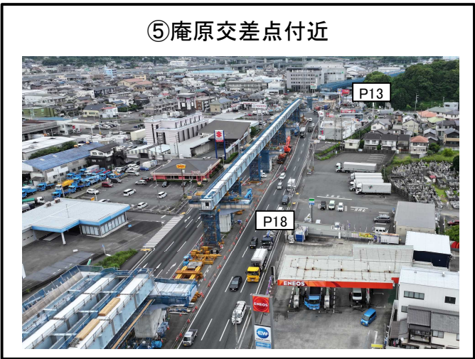
P13～P19橋脚 上部工 施工中
