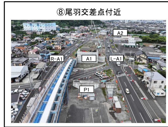
A1橋台、A2橋台間 擁壁工 施工中 A1橋台～P2橋脚 上部工 準備中 A1橋台～P2橋脚 オフランプ 施工中
