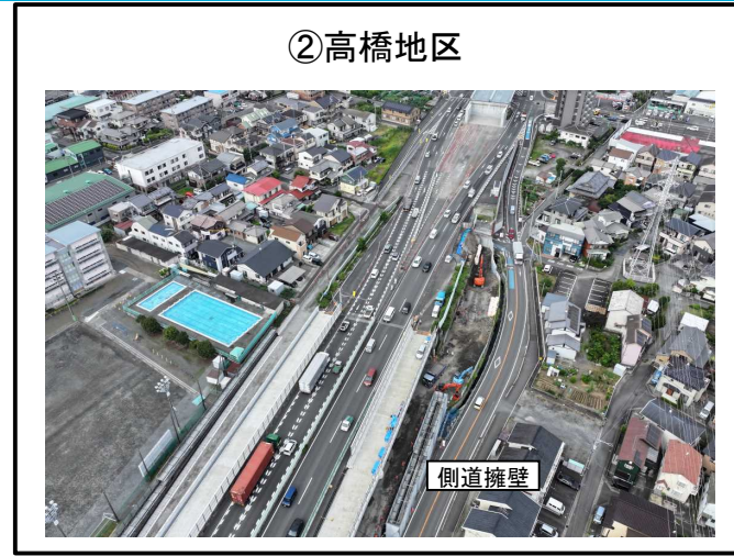
側道 擁壁 施工中
