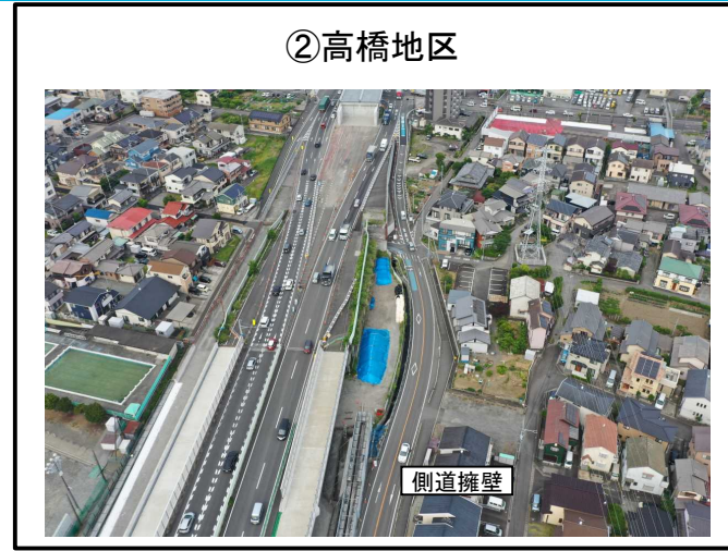
側道 擁壁 施工中
