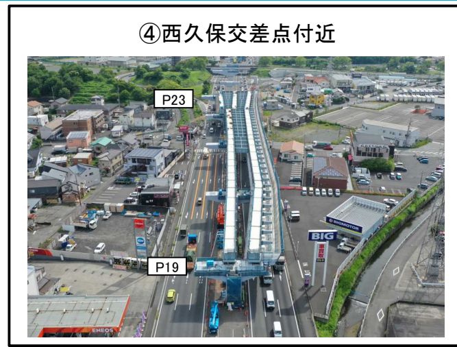
P19～P23橋脚 上部工 施工中
