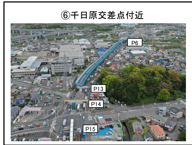
⑥千日原交差点付近 P6橋脚～P13橋脚 床版工 準備中
