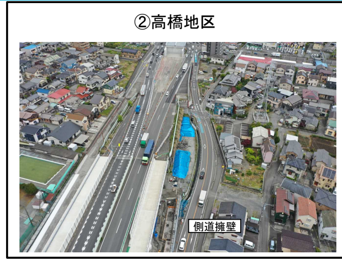
②高橋地区 側道 擁壁 施工中
