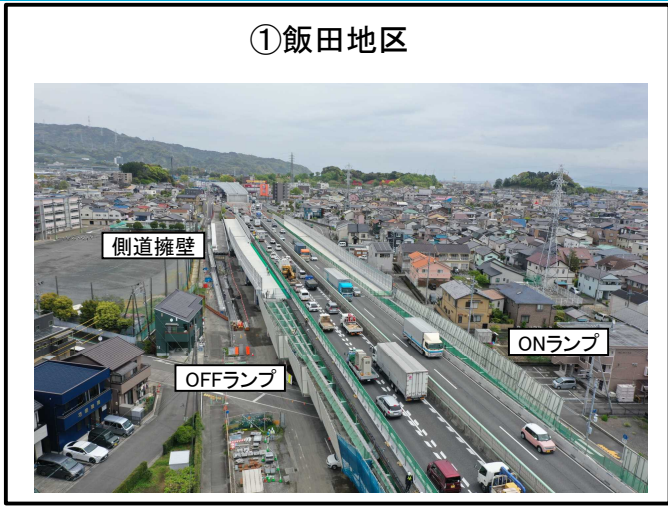
①飯田地区 飯田ON・OFFランプ合流部 上部工 施工中 側道 擁壁 施工中
