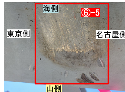
セッティングビーム下面のジャッキ痕
