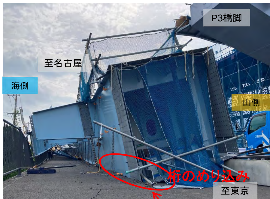
P3橋脚付近
