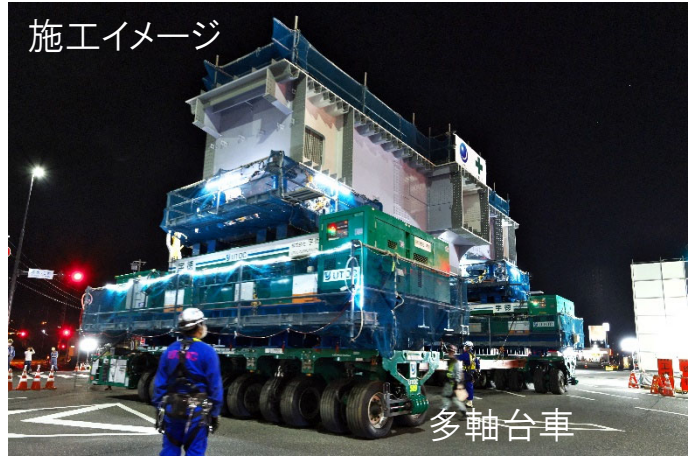
※桁架設作業は、22時～翌1時頃を予定しています
