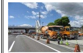
P26橋脚施工状況
