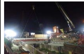
歩道PC桁架設状況
