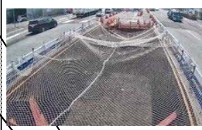
P29橋脚施工状況
