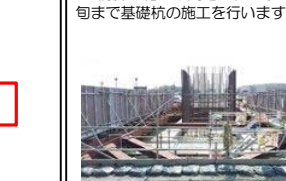
P4橋脚 施工状況
