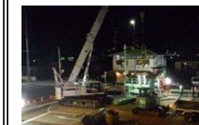
P22橋脚場所打ち杭施工状況
