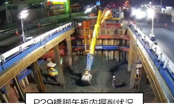
P29橋脚矢板内掘削状況
