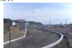
上り線尾羽地区排水構造物施工状況
