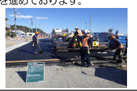
状況：上り線横砂地区舗装施工状況
