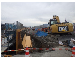
下り線八坂地区側道施工状況
