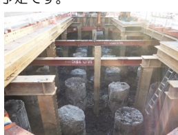
P27橋脚矢板内掘削状況
