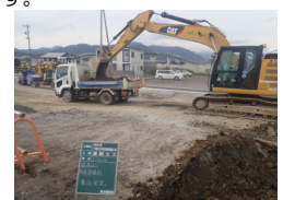
上り線尾羽地区掘削施工状況
