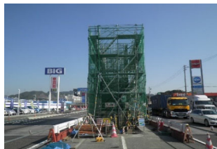
P20橋脚施工状況
