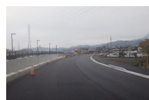
下り線横砂地区舗装施工状況
