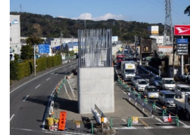
P13橋脚完成
