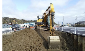
P4橋脚 掘削状況
