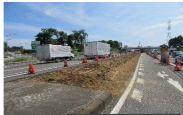
取壊し状況：P26橋脚
