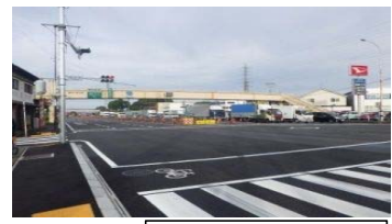
工事着手前：P22橋脚
