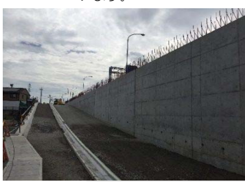
上り線 副道 施工状況
