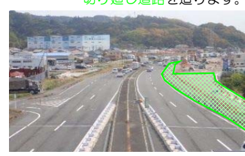
工事着手前：P3、P4橋脚
