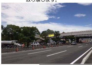
工事着手前：P27橋脚
