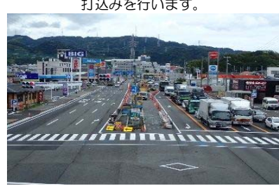
工事着手前：P20橋脚
