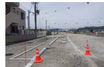
排水構造物 施工状況
