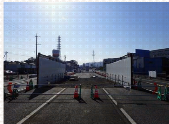
これから橋脚を施工するための掘削を行っていきます。【2月末現在】
