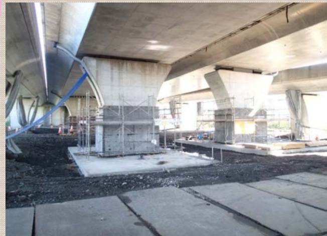
橋脚4基の補強をしています。
