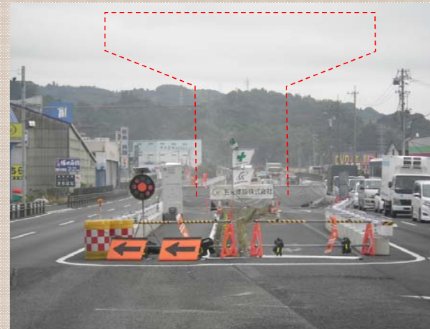
橋脚1基を造っています。
