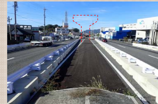
工事未着手、橋脚2基を造ります。
