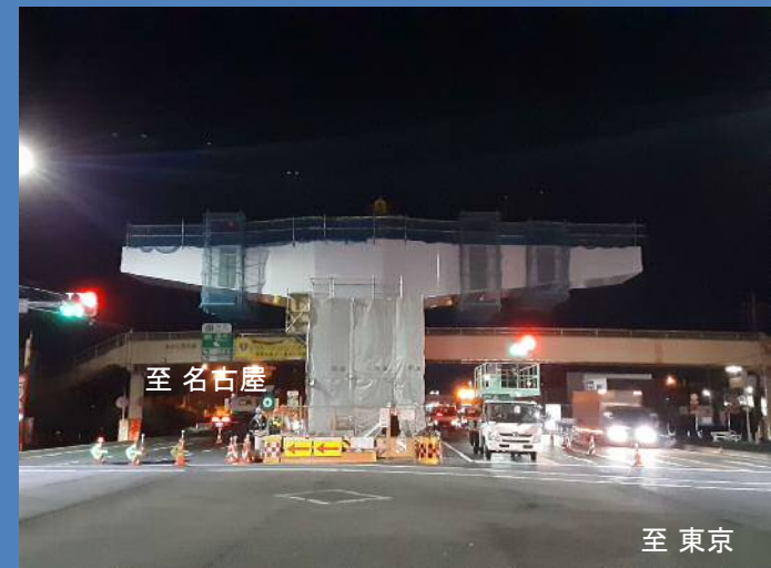
西久保交差点(上り線側)架設後
