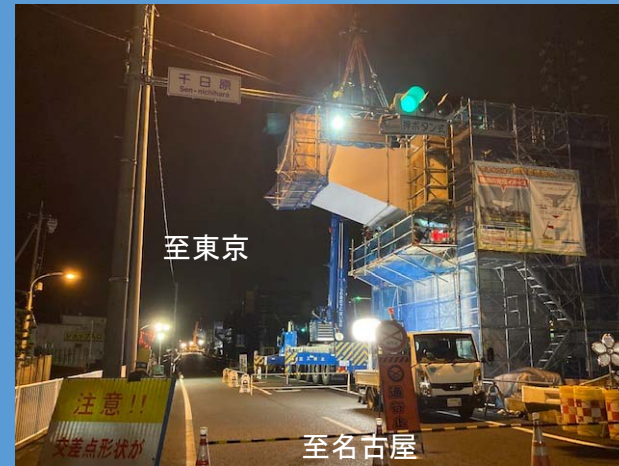
千日原交差点(上り線)の状況(7月27日晚架設)
