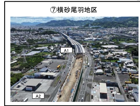
A1橋台、A2橋台間 擁壁工 施工中
