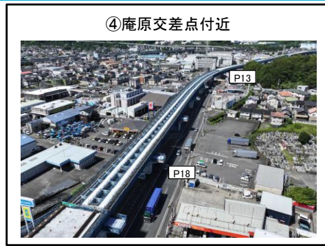
P13~P19橋脚 上部工 施工完了
