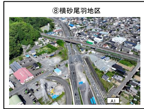
A1橋台、A2橋台間 擁壁工 施工中
