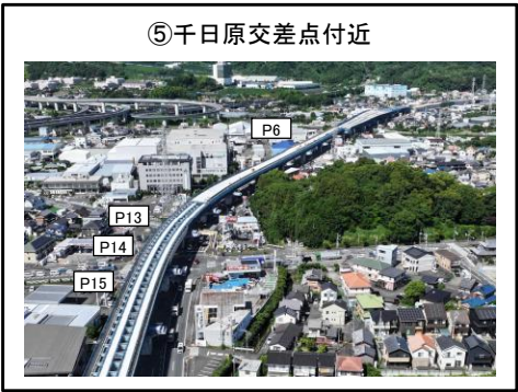
P6橋脚~P13橋脚 床版工 施工中
