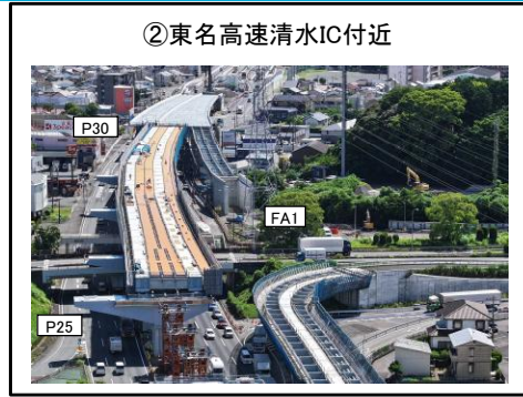
FA1~P30橋脚 上部工 施工中 P25~P30橋脚 床版工 施工中
