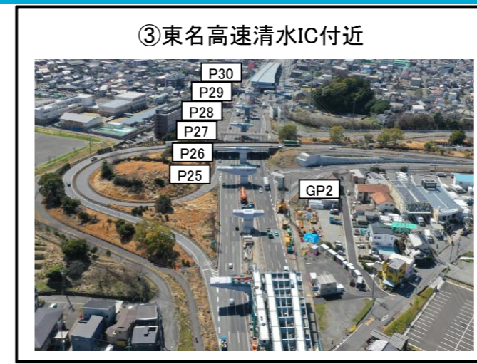
③東名高速清水IC付近 GP2橋脚 下部工 施工中 P25~P30橋脚 上部工 施工中
