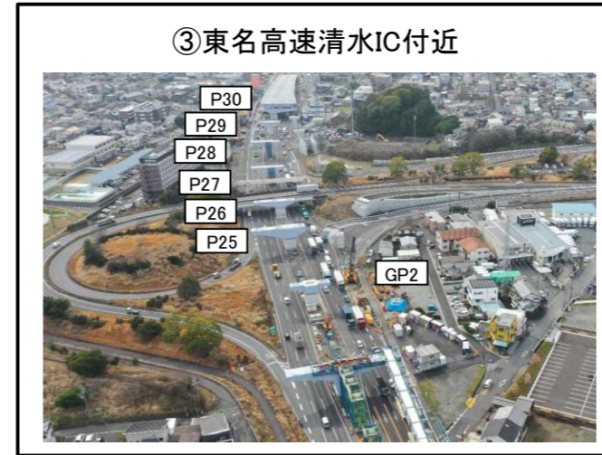
③東名高速清水IC付近 GP2橋脚 下部工 施工中 P25~P30橋脚 上部工 施工中
