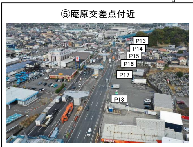
⑤庵原交差点付近 P13~P19橋脚 上部工 施工中
