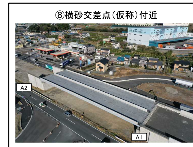
⑧横砂交差点(仮称)付近 A1橋台~A2橋台 上部工 施工完了
