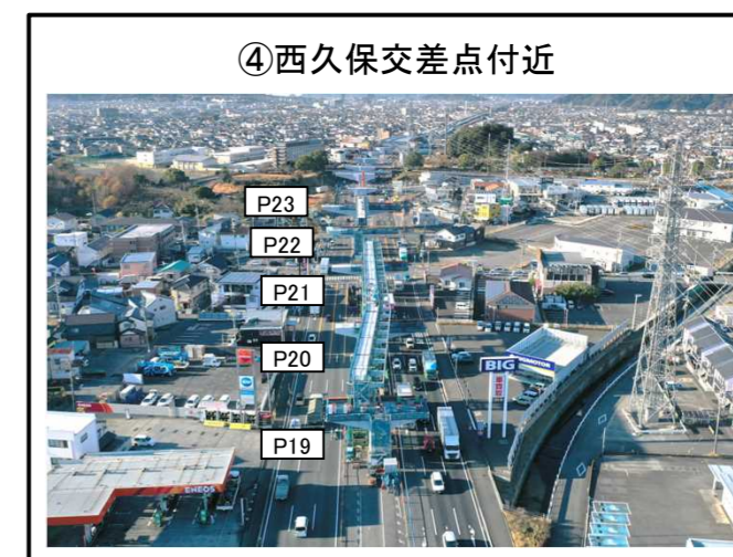
④西久保交差点付近 P19~P23橋脚 上部工 施工中
