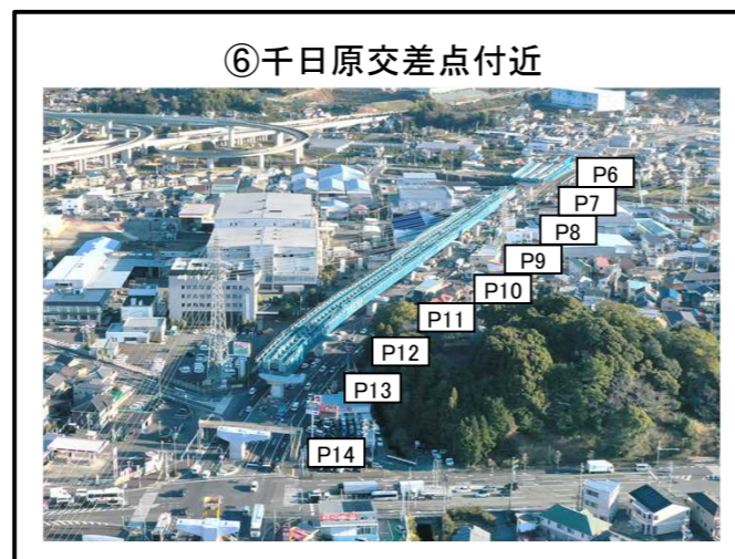
⑥千日原交差点付近 P6橋脚~P13橋脚 上部工 施工中
