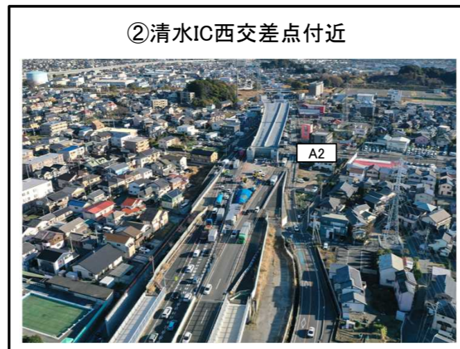
②清水IC西交差点付近 A2橋台 取付擁壁 施工中
