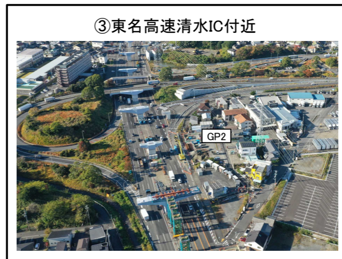
③東名高速清水IC付近 GP2橋脚 下部工 施工中
