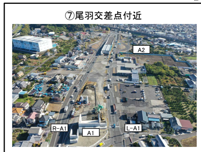
⑦尾羽交差点付近 A1橋台、A2橋台間 地盤改良 施工中
