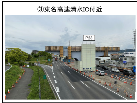
P23橋脚 鋼製梁架設 施工中
