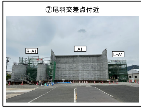
R-A1橋台、L-A1橋台 下部工 施工中
