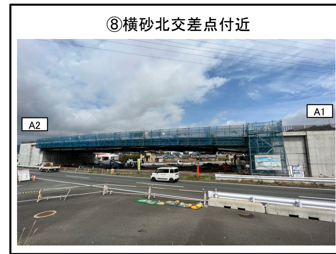
A1橋台～A2橋台 主桁架設 施工完了
