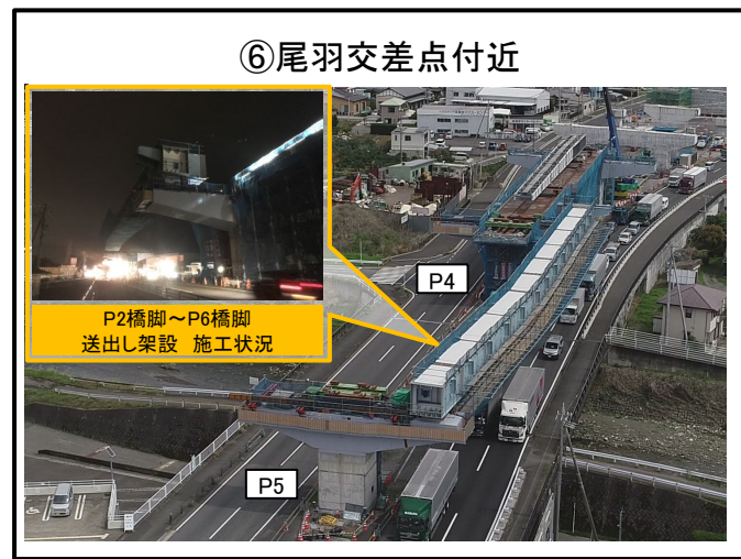
P2橋脚～P6橋脚 主桁架設 施工中
