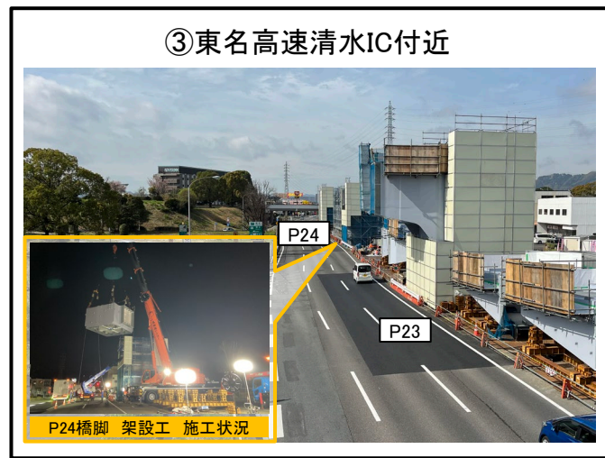
P24橋脚 鋼製梁架設 施工中
