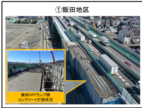
飯田OFFランプ橋 上部工 施工中
