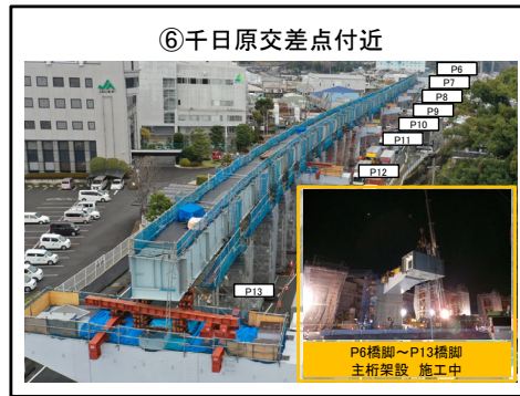
P6橋脚~P13橋脚 主桁架設 施工中
