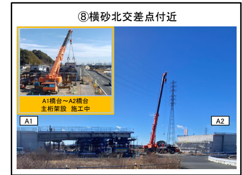
A1橋台~A2橋台 主桁架設 施工中
