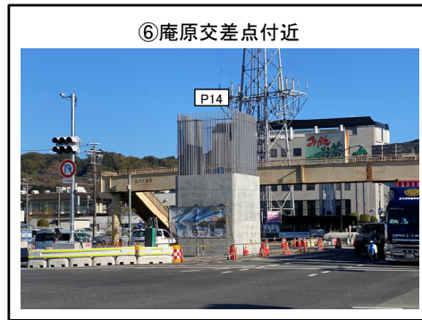
P14橋脚 下部工 施工完了
