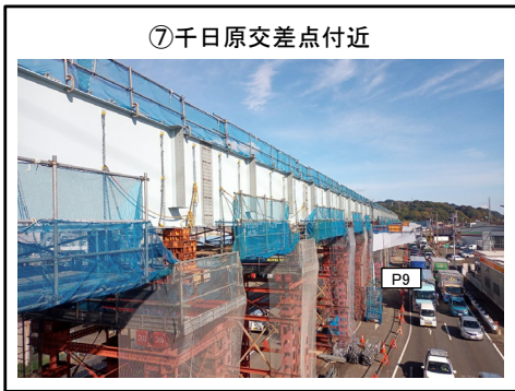
P6橋脚~P13橋脚 主桁架設 施工中
