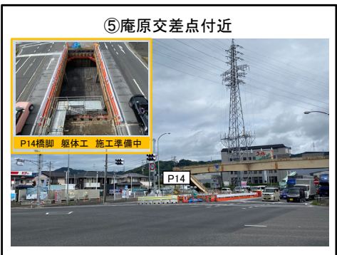
P14橋脚 躯体工 施工準備中
