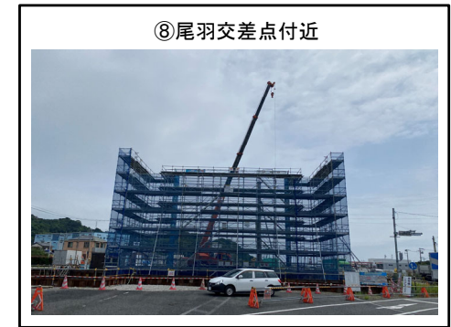
A1橋台 橋台躯体工 施工中
