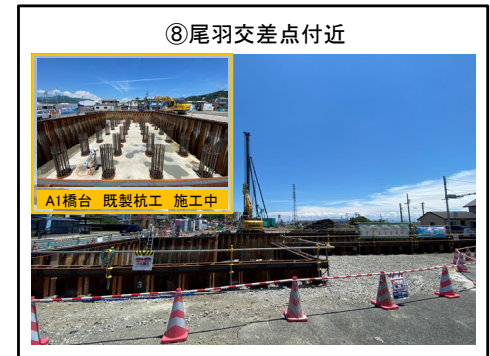
A1橋台 既製杭工 施工中
