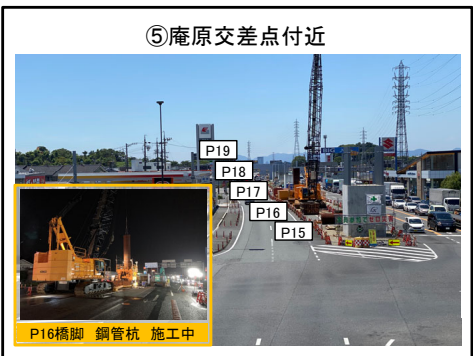
P16橋脚 鋼管杭 施工中
