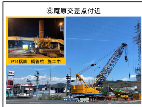
P14橋脚 鋼管杭 施工中
