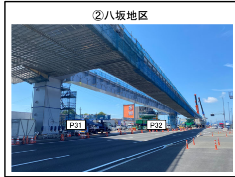
P32橋脚～P31橋脚 主桁架設(2本/3本)完了
