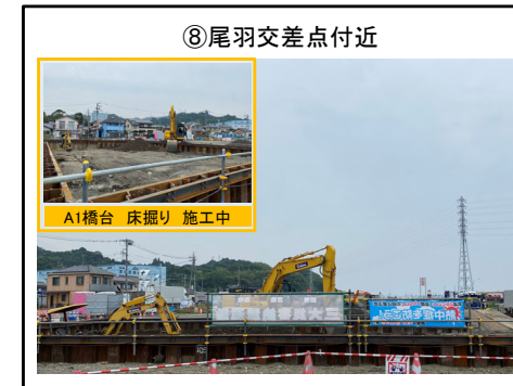
A1橋台 床掘り 施工中
