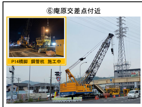
P14橋脚 鋼管杭 施工中
