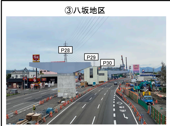
③八坂地区 P28橋脚～P30橋脚 主桁架設(1本/4本)完了
