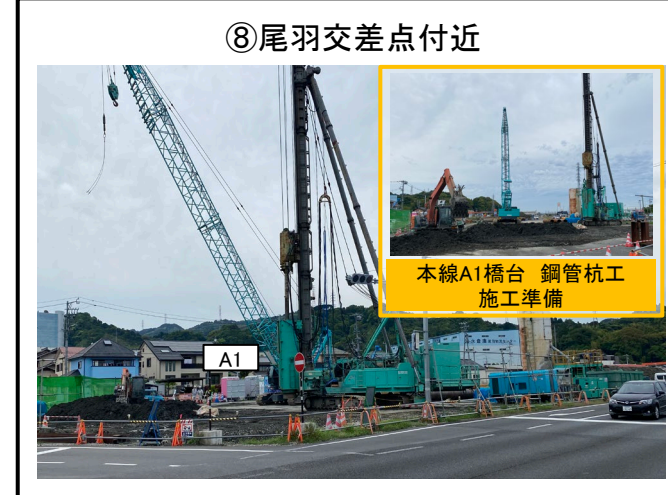
⑧尾羽交差点付近 本線A1橋台 鋼管杭工 施工準備
