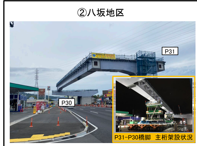
②八坂地区 P31橋脚～P30橋脚 主桁架設(1本/4本)完了
