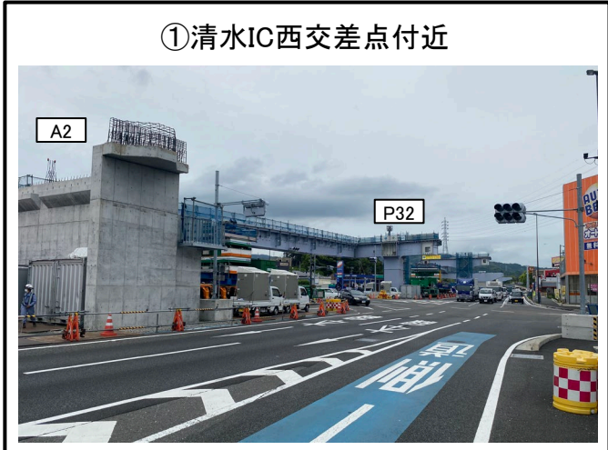
①清水IC西交差点付近 A2橋台～P32橋脚 主桁架設(1本/3本)完了
