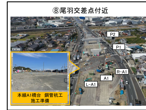
本線A1橋台 鋼管杭工 施工準備
