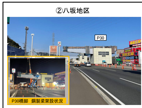
P30橋脚 鋼製梁 架設完了
