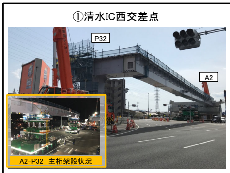
A2橋台～P32橋脚 主桁架設(1本/3本)完了
