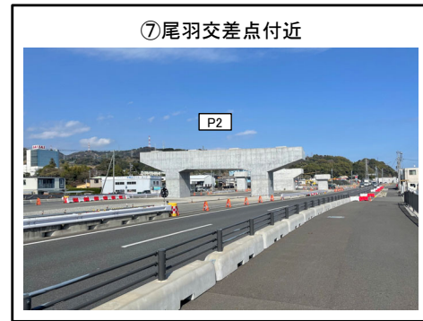
P2橋脚 工事完成
