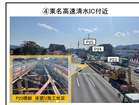
P23橋脚 床掘り 施工中
