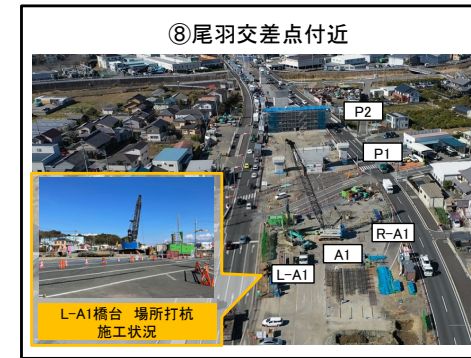
L-A1橋台 場所打杭施工中
