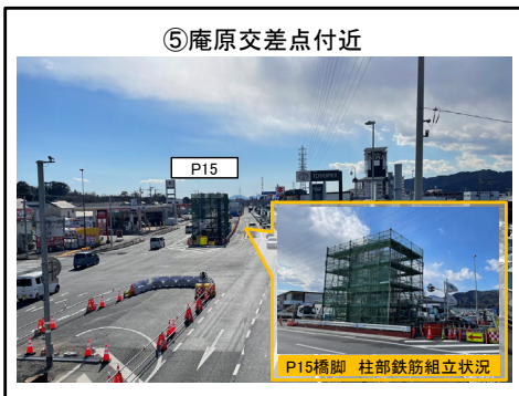
P15橋脚 柱部鉄筋組立に着手
