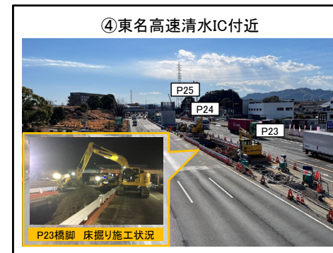
P23橋脚 床掘りに着手
