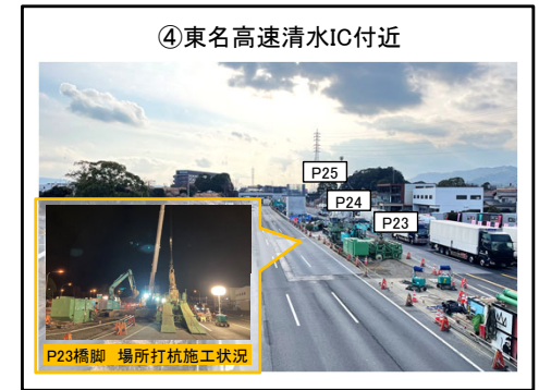
P23橋脚、P25橋脚 場所打杭工の施工中
