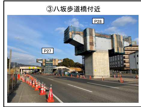
P27橋脚、P28橋脚 現場塗装工に着手
