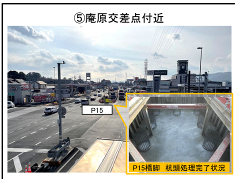
P15橋脚 杭頭処理完了
