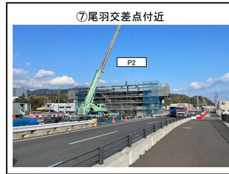
P2橋脚 躯体の鉄筋組立に着手
