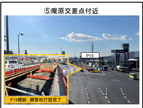
⑤庵原交差点付近 P15橋脚 鋼管杭打設完了
