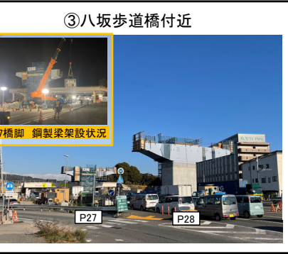
③八坂歩道橋付近 P27橋脚、P28橋脚 鋼製梁の架設完了
