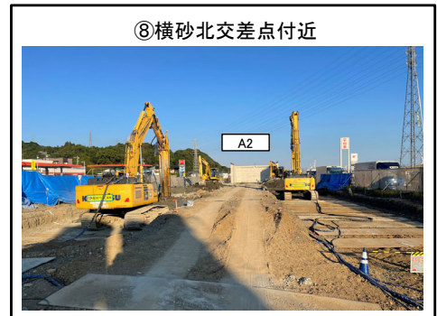
⑧横砂北交差点付近 横砂地区 地盤改良工施工中
