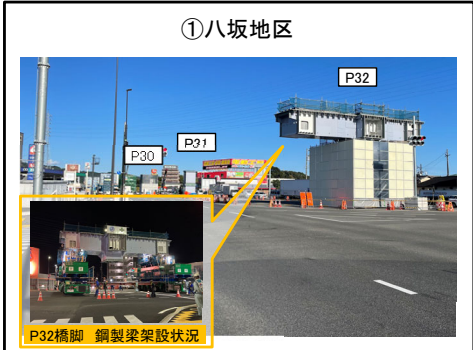
①八坂地区 P32橋脚 鋼製梁の架設完了 (R3年10月4日架設)
