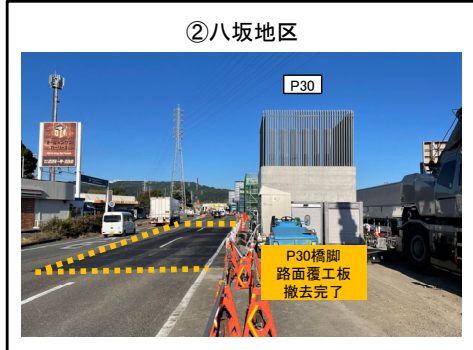
②八坂地区 P30橋脚 路面覆工板の撤去完了
