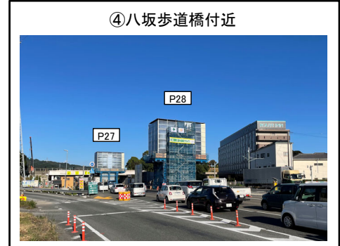
④八坂歩道橋付近 P27橋脚.P28橋脚 柱頭部架設完了
