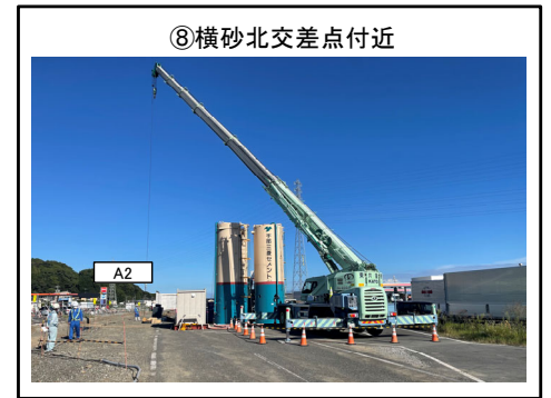
横砂地区 地盤改良工に着手
