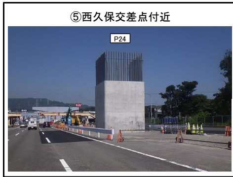
P24橋脚 コンクリート柱完成
