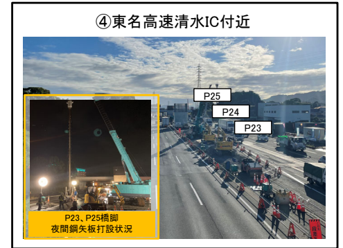
P23橋脚、P25橋脚 鋼矢板打設施工中
