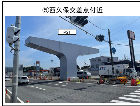
⑤西久保交差点付近 P21橋脚 工事完成
