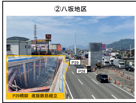
②八坂地区 P29橋脚 底版鉄筋組立に着手
