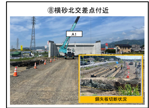
⑧横砂北交差点付近 横砂地区 鋼矢板の引抜き・切断に着手
