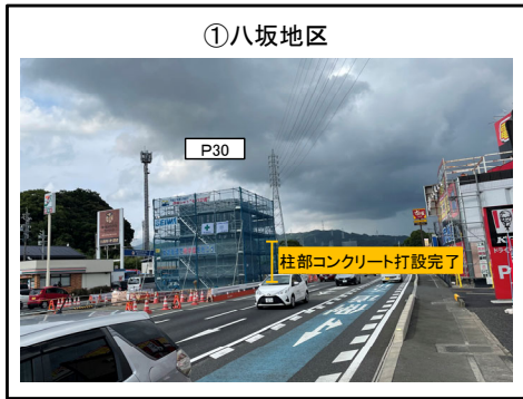
①八坂地区 P30橋脚 柱部のコンクリート打設が完了
