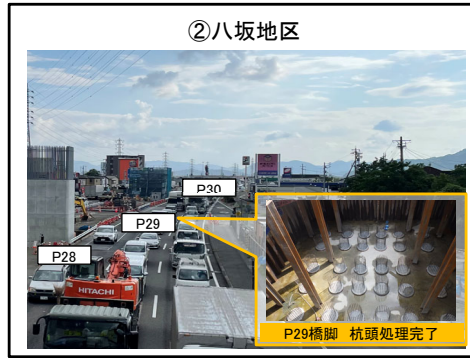
②八坂地区 P29橋脚 杭頭処理完了
