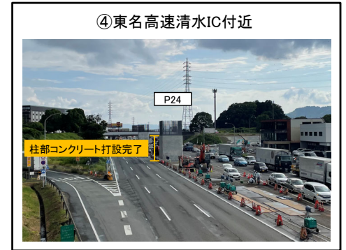
④東名高速清水IC付近 P24橋脚 柱部のコンクリート打設完了
