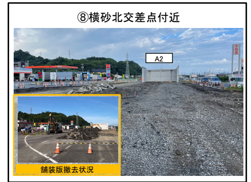
⑧横砂北交差点付近 横砂地区の舗装版撤去完了
