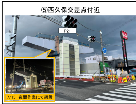
⑤西久保交差点付近 P21橋脚 鋼製梁の架設完了
