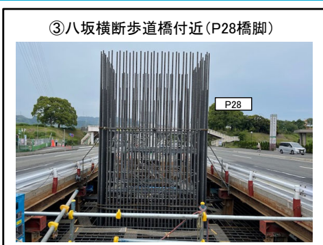
P28橋脚の鉄筋組立完了
