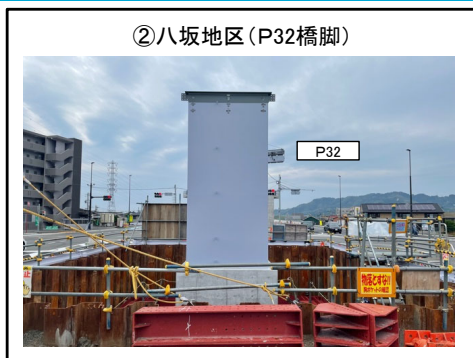
P32橋脚の柱部架設完了
