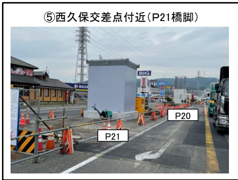
P21橋脚の柱部架設完了
