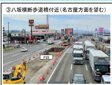
P28橋脚の床掘施工中
