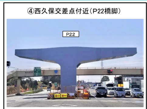
P22橋脚の鋼製橋脚(梁部)架設完了
